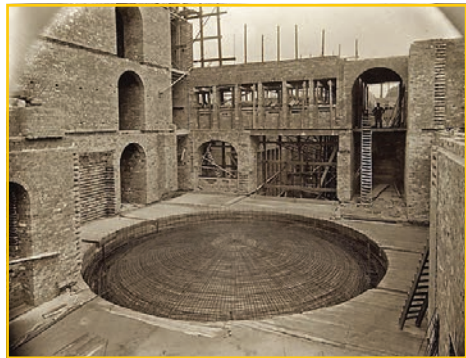
Bodenplatte der Rotunde im Bau | Foto ©: Architekturmuseum der TU München
