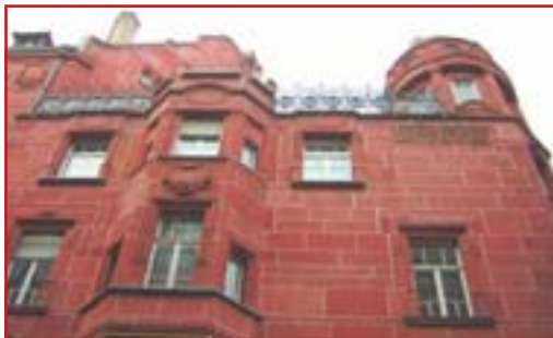
Fugen lassen die Außenhaut organisch erscheinen
