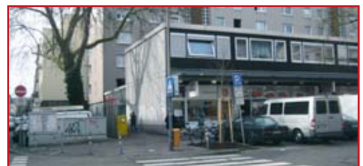
Der Gehweg der Ladenzeile Sophienstraße soll verbreitert werden.
