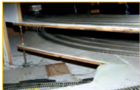
Die Gewindestange der Gleiswendel sind verrostet und die Trassenbretter verzogen.
