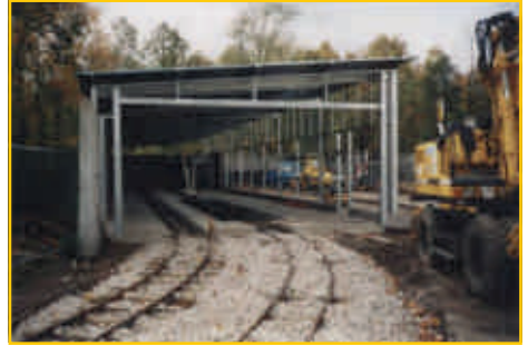
Der neue Fahrzeugschuppen auf dem Gelände des ehemaligen Heizkraftwerks am Aha-Weg. Aufnahme: D. Skowronek.
