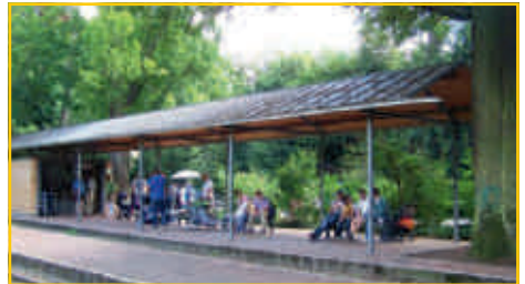
Die neue Überdachung mit pflegeleichter Dachschräge. Aufnahme: St. Viel.
