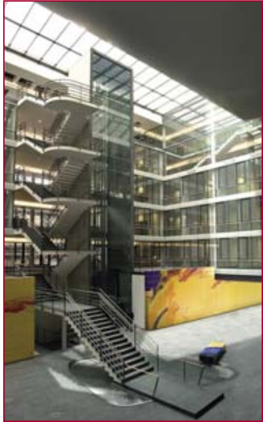
22 Meter lichte Höhe werden im Sparkassen-Neubau in der westlichen Kaiserstraße durch das zentrale Treppenhaus und die gläsernen Fahrstühle erschlossen. Einen besonderen Blickfang im Atrium bildet obendrein das Raumkunstwerk „Oase“.
