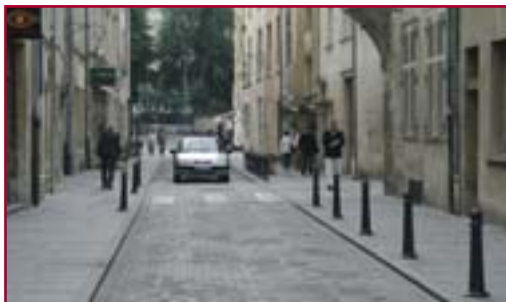
Eine Gasse mit Pollern und Entwässerungsrinne
