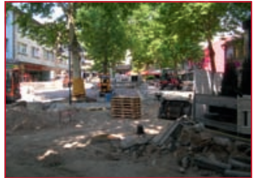
Baustelle im Passagehof
