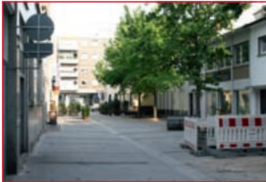
Baustelle im Hirschhof kurz vor Fertigstellung
