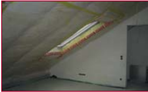
Zwischensparrendämmung im Neubau
